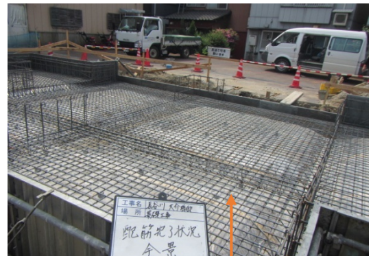
構造計算した配筋
