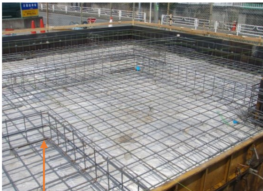
等間隔ピッチの配筋
